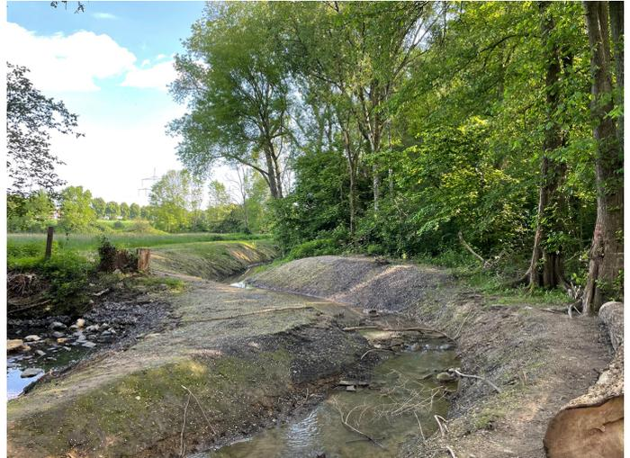
Anstauschwelle (links) und reaktivierter Bachlauf des Harpener Bachs (rechts) (Quelle: STM WLAB)
