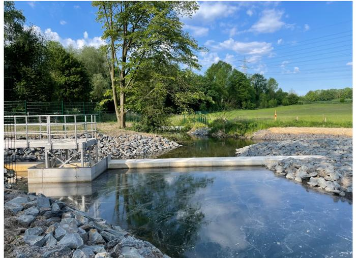
Einleitung des Grubenwassers in die Harpener Teiche (links) und Wasserweiche (rechts) (Quelle: STM WLAB)
