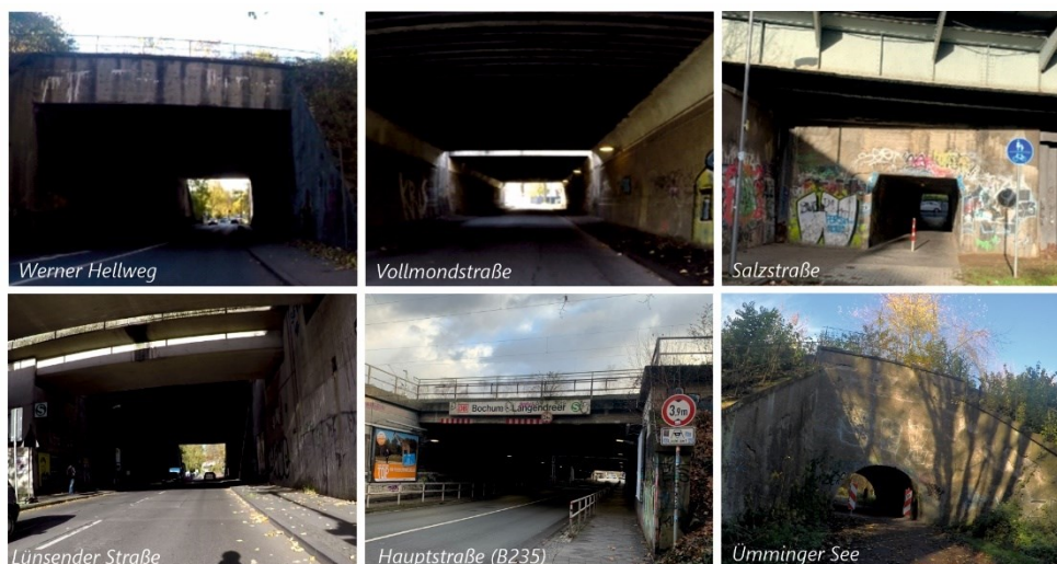
Bild 16: Unterführungen im Projektgebiet (Fotos: IGS mbH)
