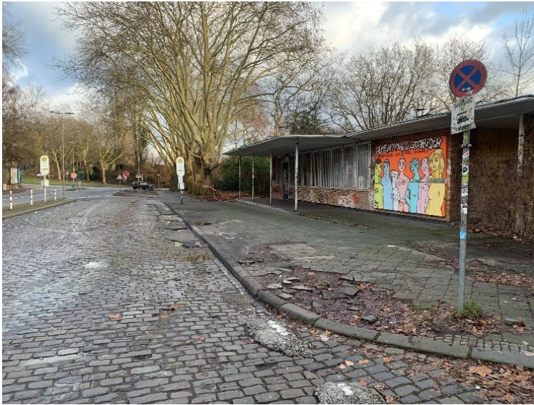
Bild 15: Fehlendes Pflaster am Wallbaumweg im Bereich des Bahnhofs – Haltestelle Langendreer-Nord (Foto: IGS mbH)
