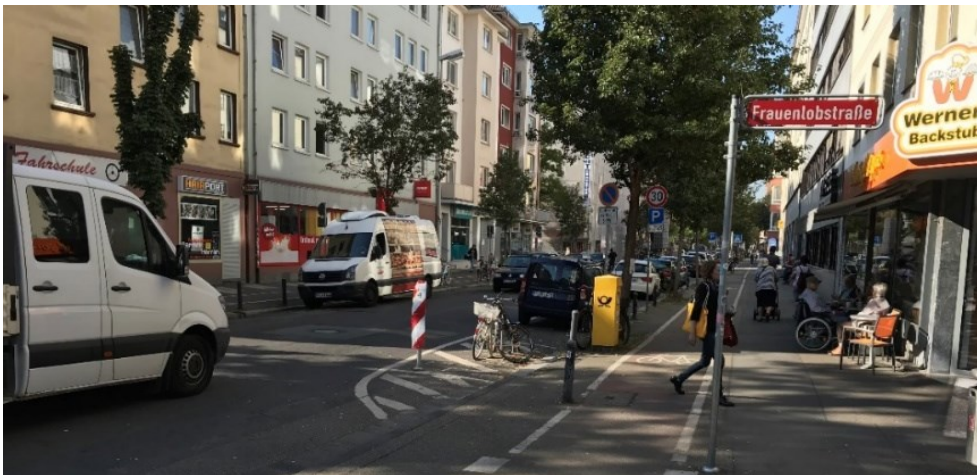
Bild 14: Installation von Abstellbügeln im Einmündungsbereich zur Verbesserung der Sichtbeziehungen (Foto: IGS mbH)
