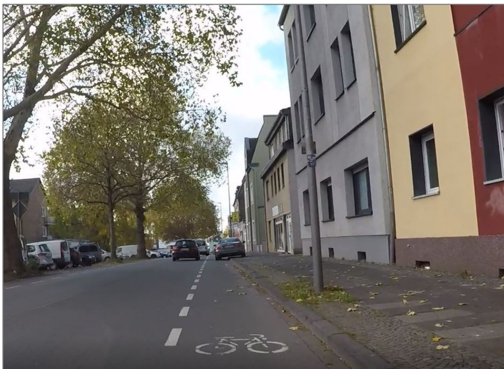
Bild 12: Schutzstreifen auf dem Werner Hellweg östlich Kreyenfeldstraße (Foto: IGS mbH)
