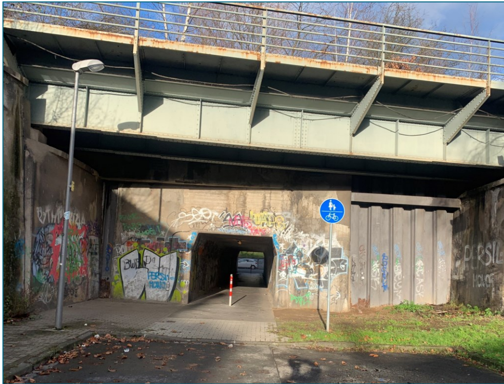
Bild 8: Unterführung Salweidenbecke – Hohlstraße (Foto: IGS mbH)
