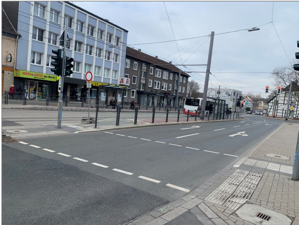
Bild 21: Querungsstelle mit differenzierter Bordsteinhöhe auf der Hauptstraße (Foto: IGS mbH)
