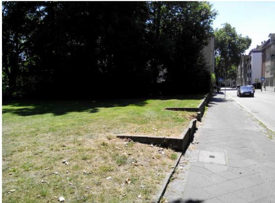
Abb. 124: Defekte Winkelsteine längs der Lünsender Straße, Foto 2018
