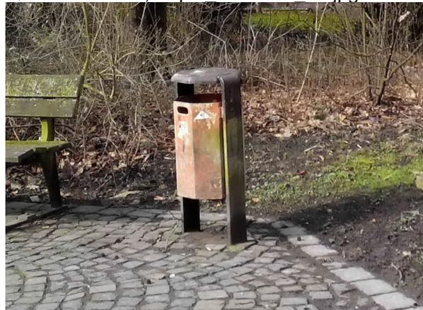
Abb. 141: Papierkorb mit Überdachung und schadhafter Lackierung
